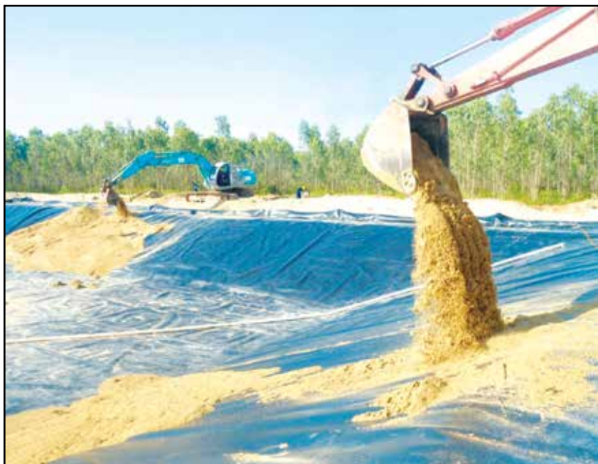
Đất nhiễm dioxin được chôn lấp thụ động tại sân bay Phù Cát, tháng 3/2012. Dự án hoàn thành vào ngày 18/8/2012. Ảnh: Lê Kế Sơn
