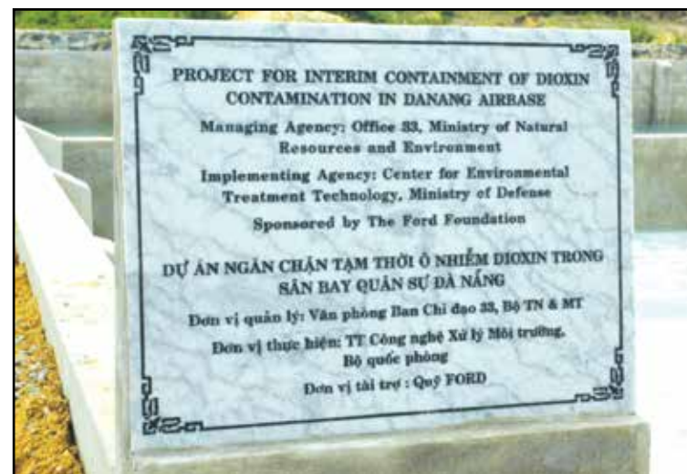
Quỹ Ford tài trợ xây dựng lớp bê tông bao phủ và hệ thống thoát nước để ngăn chặn lan toả dioxin tại sân bay Đà Nẵng, tháng 1/2008.
